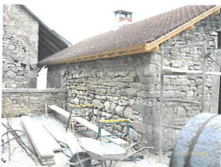
Préparation des murs pour la pose des joints par l'entreprise SIMONETTA
