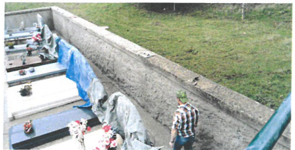
Crépissage et pose d'un grillage sur mur intérieur et jointement des pierres côté extérieur par l'entreprise Simonetta
