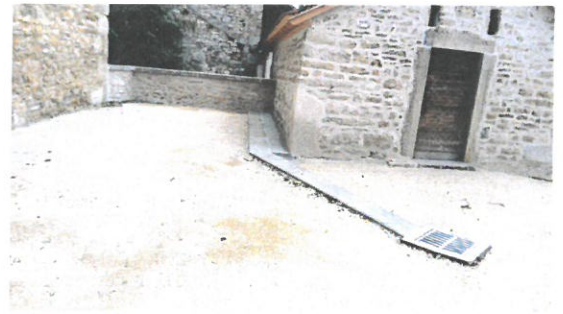
Préparation des abords avec la pose d'un caniveau par l'entreprise de Sylvain Marguier
