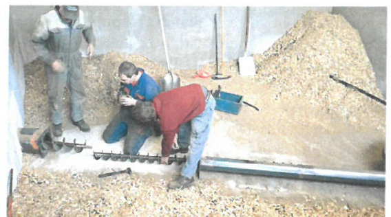
Changement de la vis d'extraction du silo par Dominique Besson, Jean-Pierre Montjouvent avec l'aide de l'employé communal.
