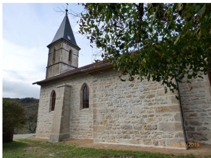
Réfection de la façade sud.
