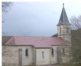
Réfection de la totalité de la toiture en tuiles écaillés.
