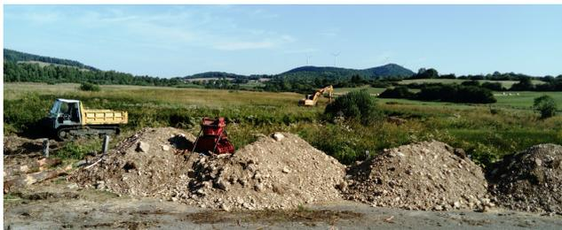
Suite à la fermeture du puits de captage situé sur le marais de Jarine, les travaux ont pu reprendre sur la zone de protection rapprochée. Il s'agit du remblaiement des différents fossés et de la réhabilitation du lit de la Jarine.
