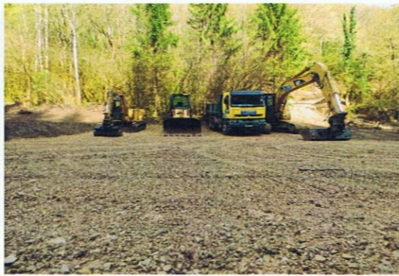
Création d'une place de dépôt et de retournement en amont de la ferme de Malaval
