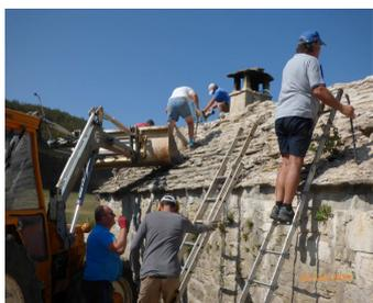
La toiture en lauses du four de Rougemont a été démontée par des bénévoles du village que nous tenons à remercier pour leur implication. Cette toiture a été remplacée par une charpente bois recouverte de tuiles écaillés. Les travaux ont été réalisés par l'entreprise l'Herminette
