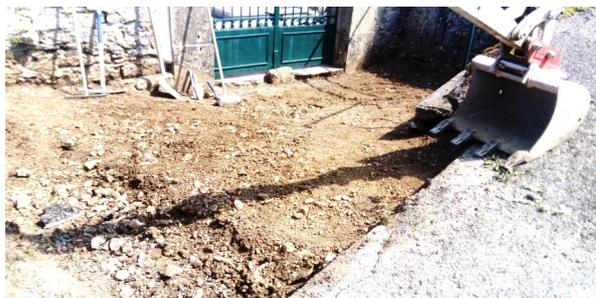
Le pourcentage de la pente d'accès au cimetière a été diminué par la pose d'un béton antidérapant, et la création d'une rampe le long du mur par l'entreprise PST (S.Marguier).
